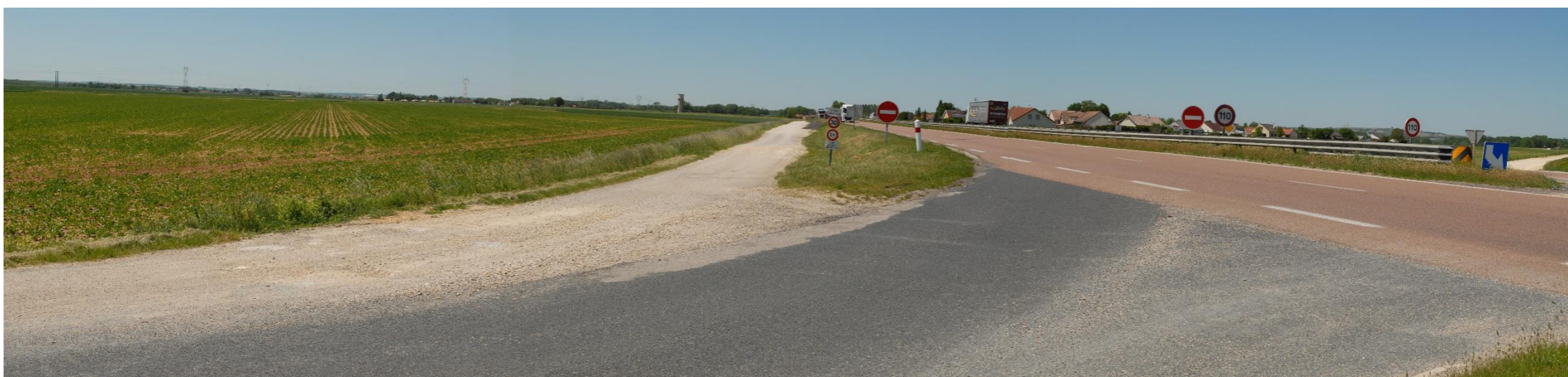
Le site en projet occupé par des cultures, le chemin latéral sud, la RN 4 et le quartier de la Haie des Vignes, vus depuis l'angle de la RD 58 et du chemin rural latéral sud à la RN.4.
